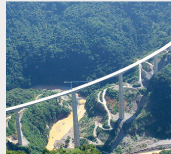
Viaducto Borja Gil Navarrete. Autopista de Nuevo Necaxa-Tehuacán. Enrique Díaz.
