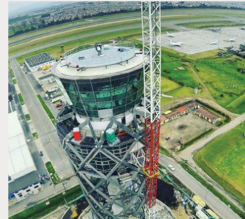
Construcción de la nueva torre de control del aeropuerto del Dorado. Manuel Peña
